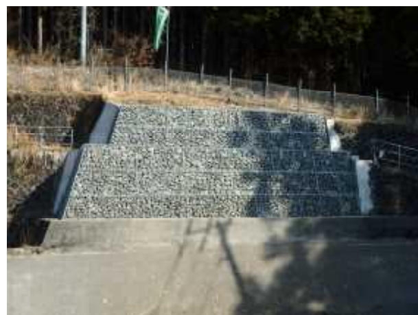
鋼製カゴ砕石積
