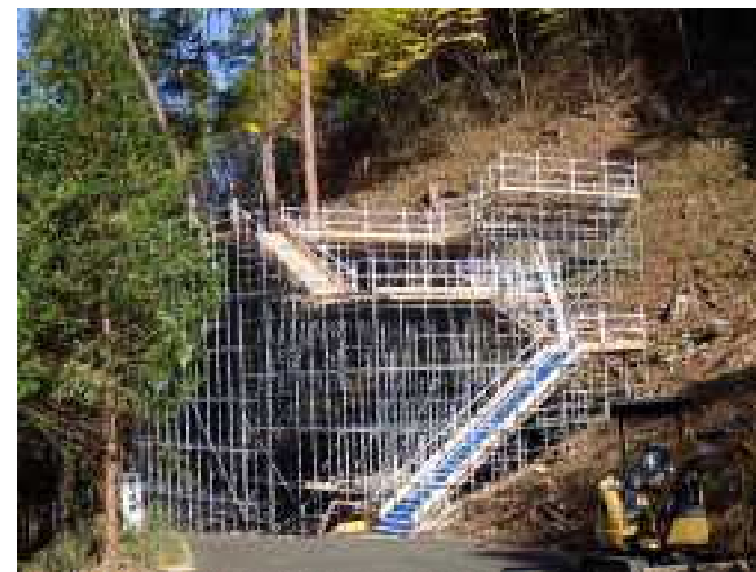
特殊ステージ足場
