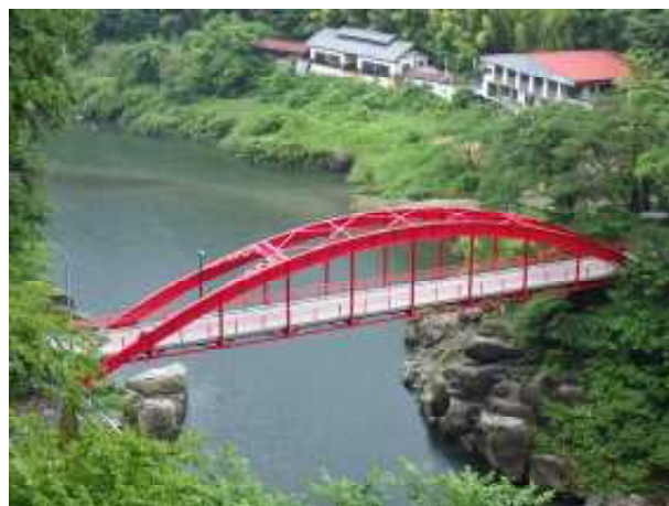
棧橋修繕工事
