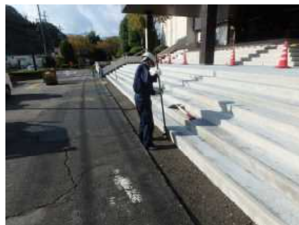
木曽合同庁舎玄関工事 (スーフィーネ施工)
