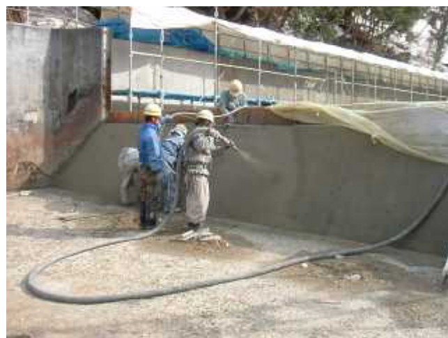
特殊モルタル吹付施工
